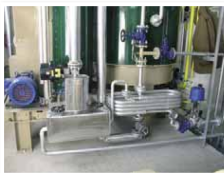
Detailní pohled z ochozu kotelny – měřící místo emisí (2 × 5,5 tun páry/hod)
